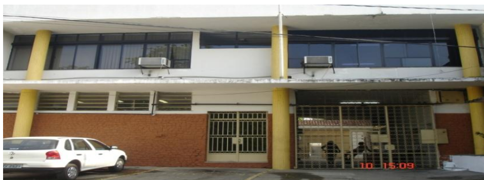
Figura 16. Hospital de Custódia e Tratamento Heitor Carrilho, atual Instituto de Perícias Heitor Carrilho. 2016.
