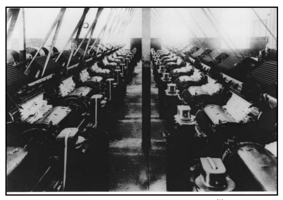
Figura 19: Seção de maçaroqueiras da fábrica Mavilis. S/D.<sup>215</sup>
