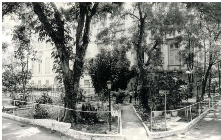
S. Castellano. Praça interna IBC, conhecida por Praça dos Ledores. Acervo fotográfico do Museu do IBC. Rio de Janeiro: IBAC, 1995.
