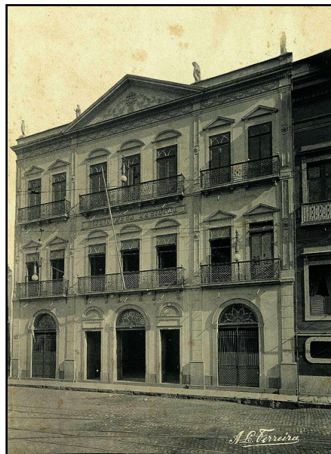
Figura 5 – Prédio da Real Biblioteca, na Rua do Passeio
