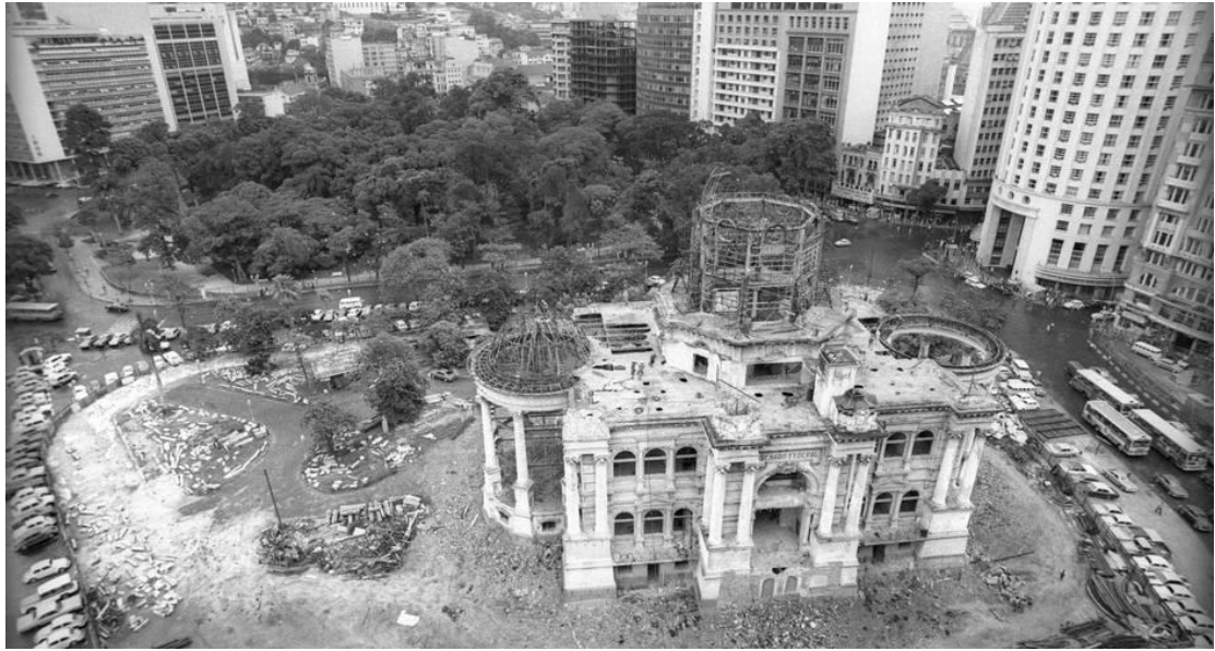
Fig. 23: início da demolição (Alcyr Cavalcanti/Acervo O Globo)
