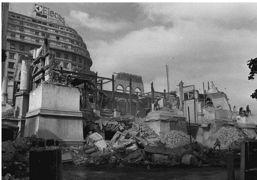
Fig.31: Palácio na fase final da demolição (Arquivo Público do Rio de Janeiro)
