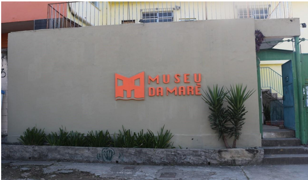
Figura 2 - Fachada do Museu da Maré. (Autora, 2019).
