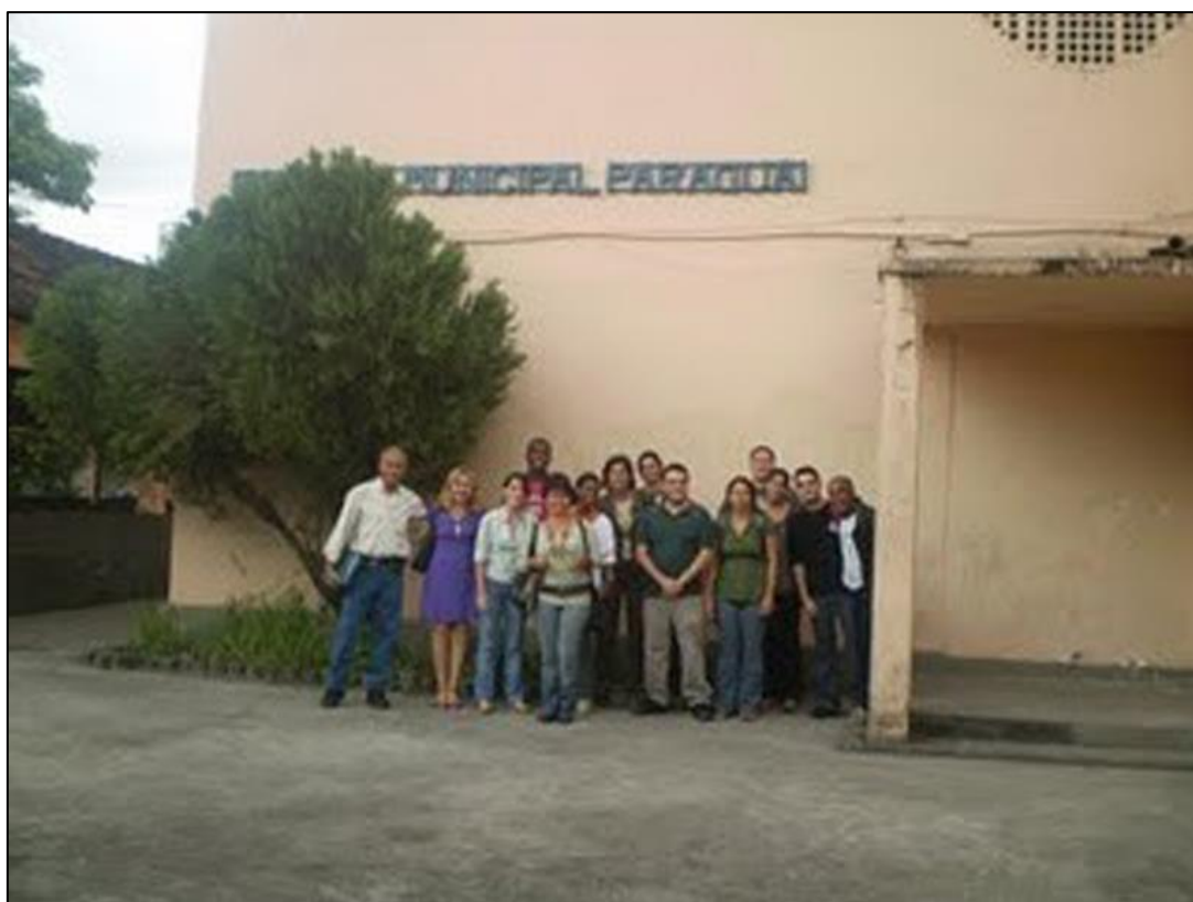
Figura 1. A Escola Municipal Paraguai. Localizada no Bairro de Marechal Hermes, Zona Norte do Rio de Janeiro.
