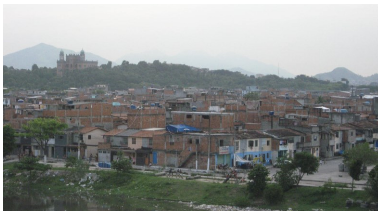
Imagem 4: Visão da Maré e do Castelo da Fiocruz, ao fundo, à esquerda. Fonte: Favela da Maré. Autor/fonte: Julius Wikimedia Commons
