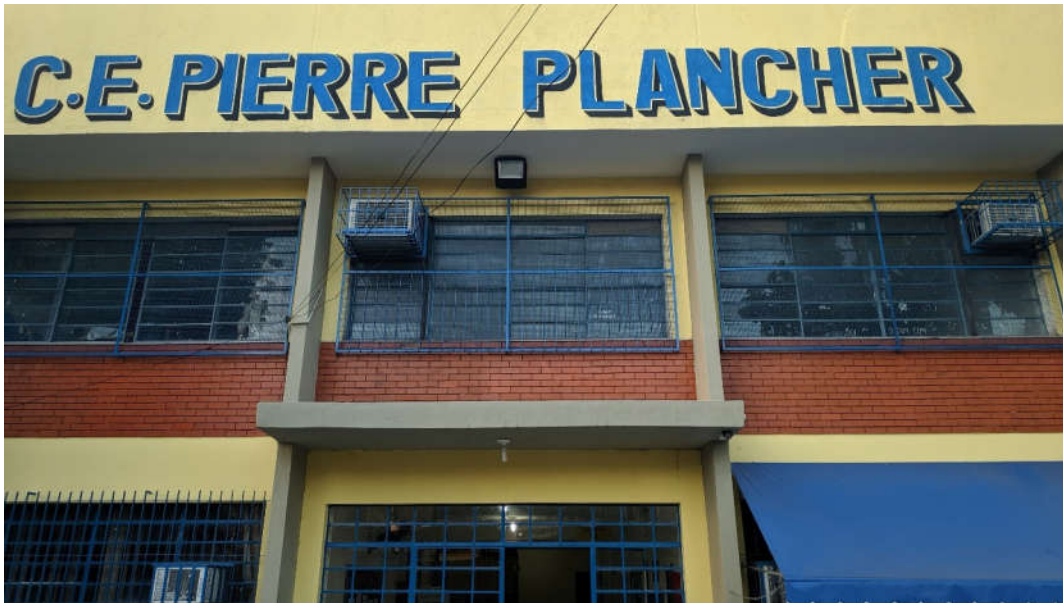
Figura 7.1 – Fachada do C. E. Pierre Plancher Fonte: Foto tirada pelo autor
