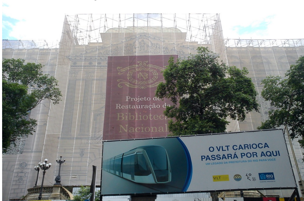
Figura 11 – Biblioteca Nacional em obras
