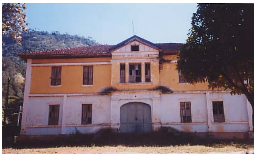
ILUSTRAÇÃO 31 – Vista frontal de antigo pavilhão da FEEM, Fazenda São Domingos. Fotografia: Liza Uema, agosto de 2004.
