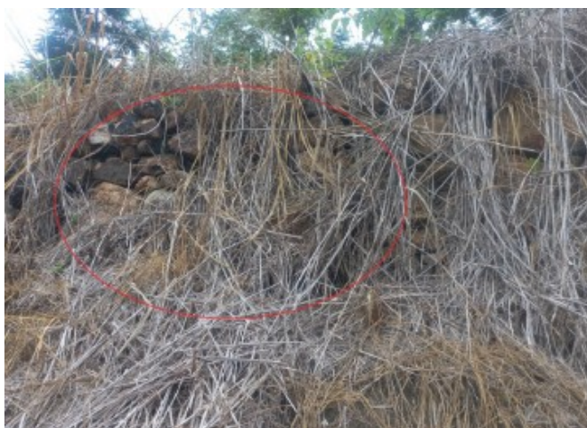
Figuras 19: Muro de contenção
