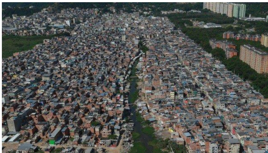
Figura 11 – Vista aérea de Rio das Pedras
