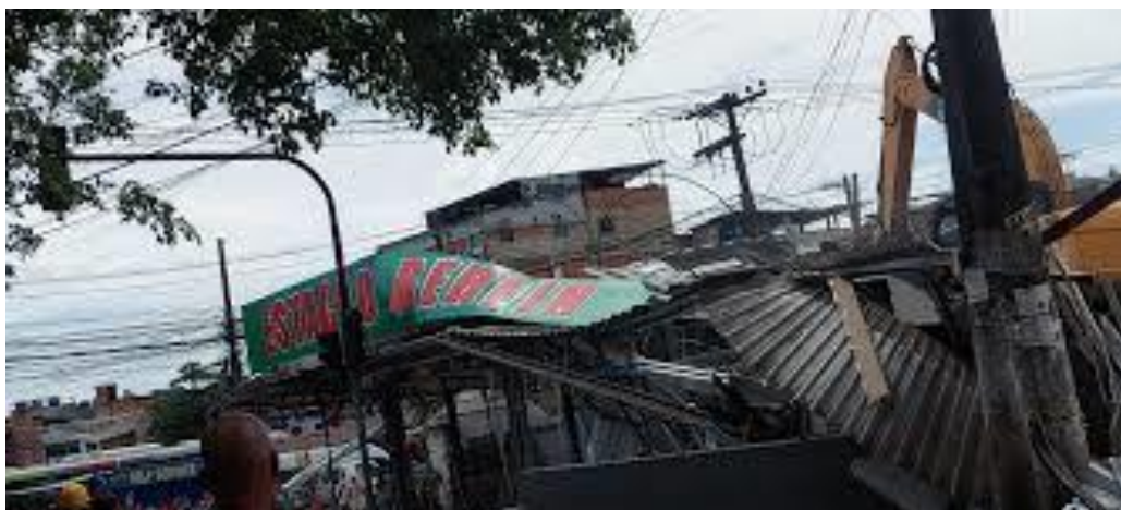
Figura 22 – Demolição de bar construído irregularmente em Rio das Pedras
