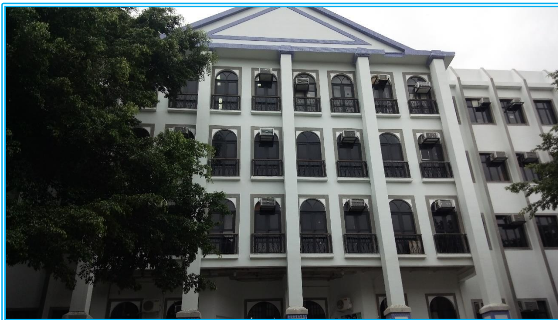
Figura 8 - Prédio do CCH
