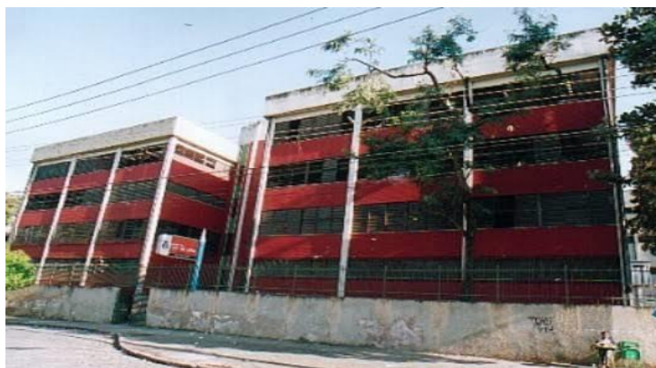
Imagem 15 Prédio da Escola Cardeal Leme em Benfica Zona Norte (RJ)
