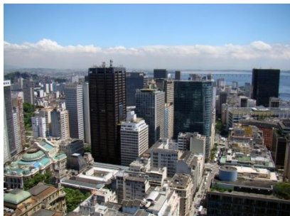
Vista aérea do Centro
