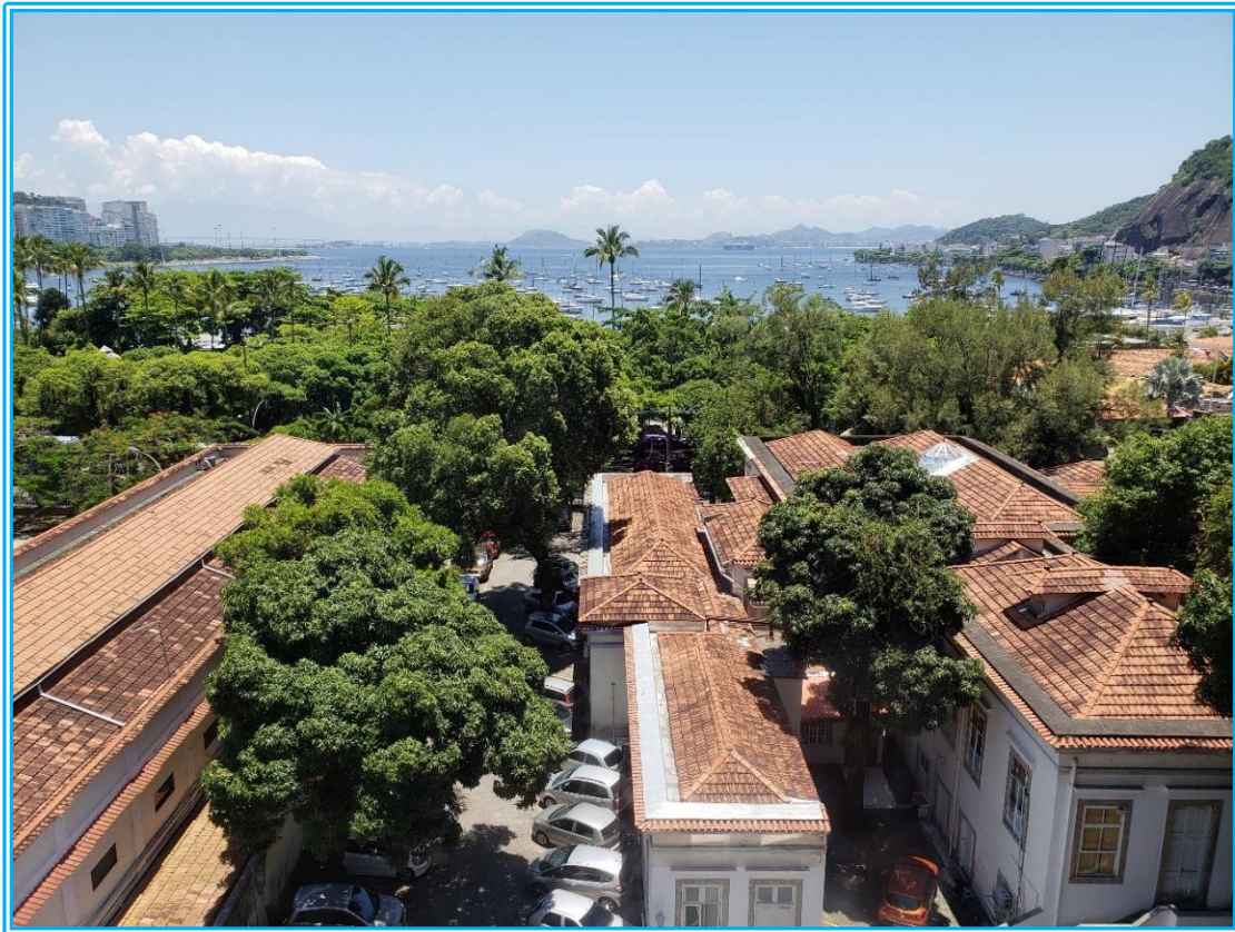
Figura 13 - Vista da Unidade Av. Pasteur, 296
