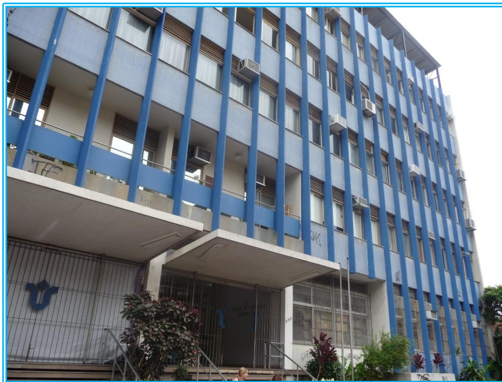
Figura 17 - Unidade R. Xavier Sigaud - Fachada da EEAP
