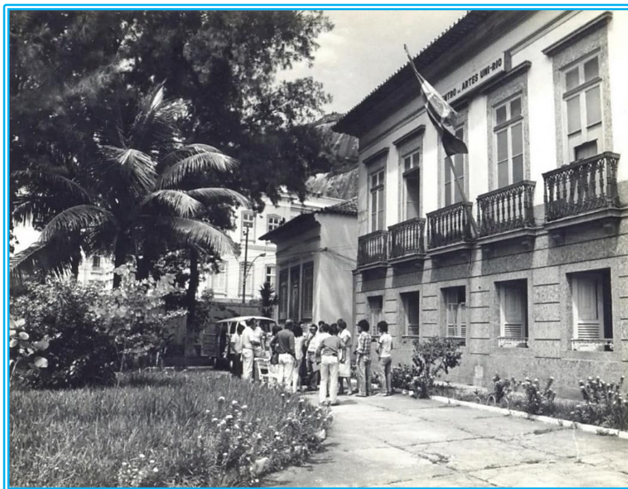
Figura 1 - Antigo Centro de Letras e Artes, atual prédio da Reitoria da UNIRIO
