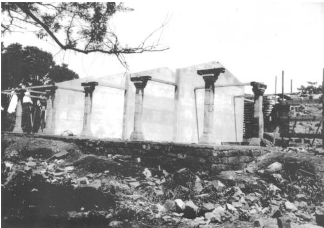
Museu das Missões em construção. Foto: Arquivo Iphan – São Miguel das Missões/ RS
