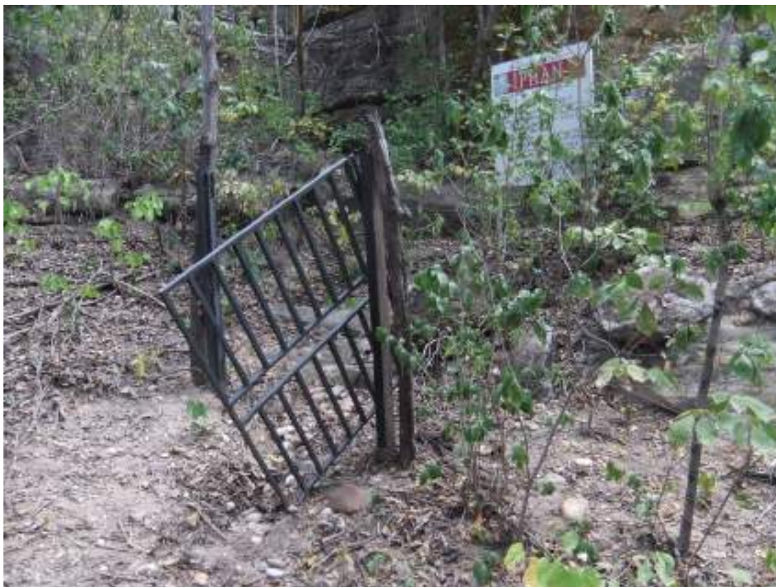
Foto 56: infraestrutura de proteção sob ação natural. Veredão VI. IPHAN, 2012.
