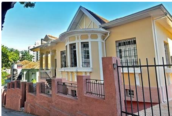
Figura 39 - Fachada restaurada do Edifício em 2014.
