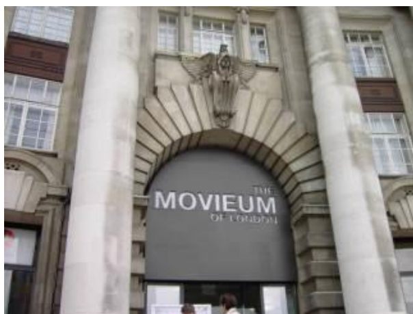
Figura 1 - Edificação do Movieum
