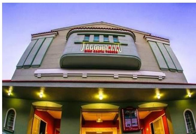
Figura 41 - Fachada restaurada do Edifício em 2016.
