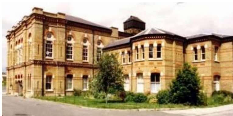
Figura 2 - Edificação do Museu de Cinema, em Londres
