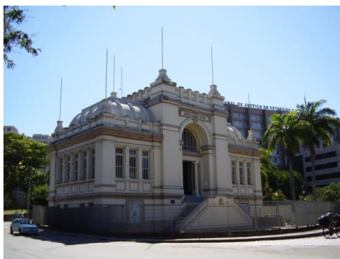
Figura 28 – Fachada da primeira sede do MIS-RJ
