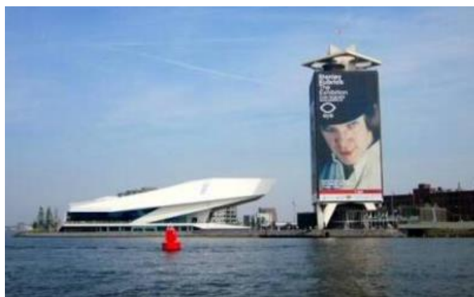
Figura 4 - Edificação do EYE
