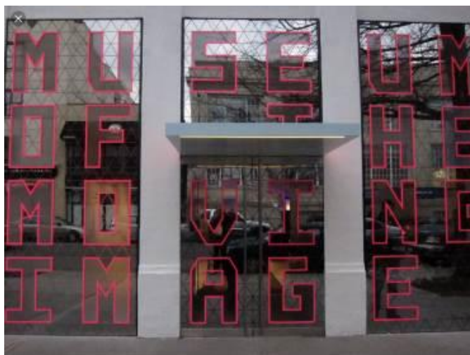
Figura 26 - Edificação do American Museum of the Moving Image, em Nova Iorque
