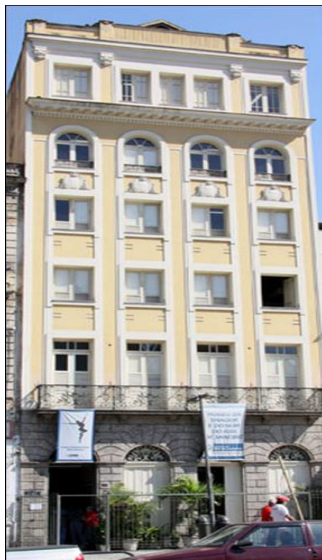
Figura 29 – Fachada do prédio anexo do MIS-RJ na Lapa
