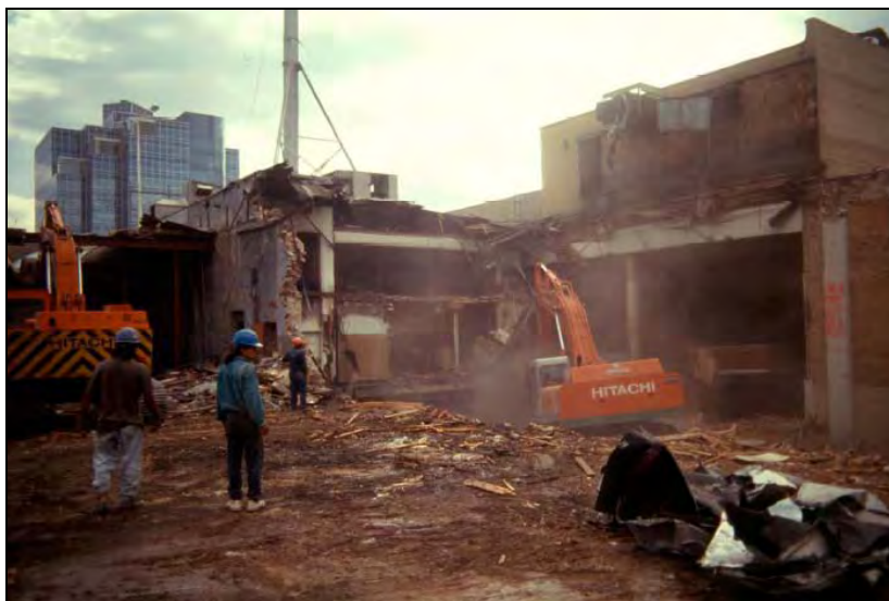
Fotografia 5 - Demolição de um dos 57 edifícios, em Salt Lake City, antes da construção do parque temporário. Foto: Stephen Goldsmith
