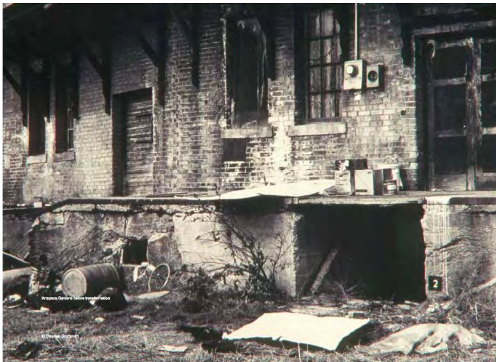
Fotografia 13 – Imagem de Artspace antes da transformação De: Stephen Goldsmith
