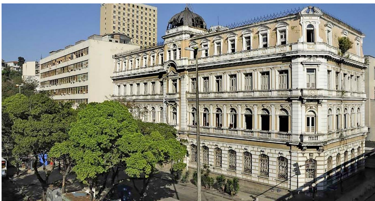
Figura 1 - Edifícios do Museu de Arte do Rio antes das obras.
