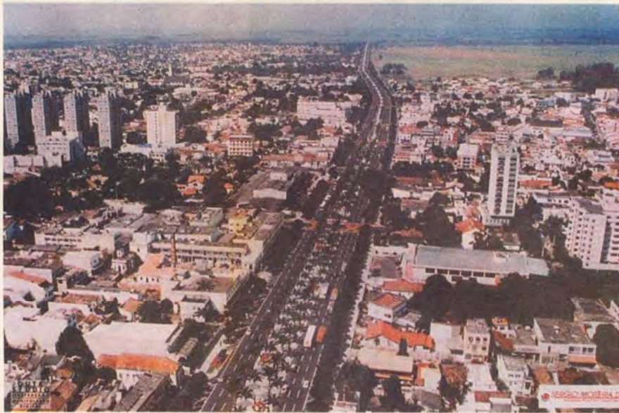
CANAL Vista aérea do canal Campos-Macaé, coberto com palmeiras e ipês remanejados
