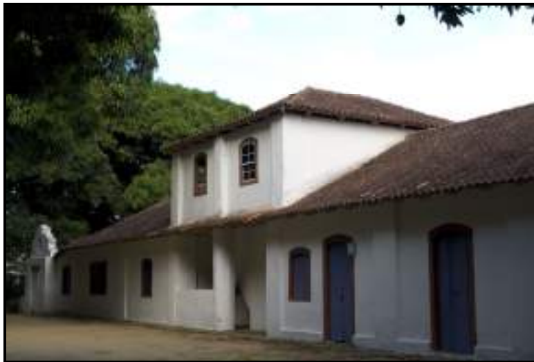
Fotografia 8 - IBRAM. Fachada do Museu Solar Monjardim , [20-]. Foto localizada no site do Instituto Brasileiro de Museus.
