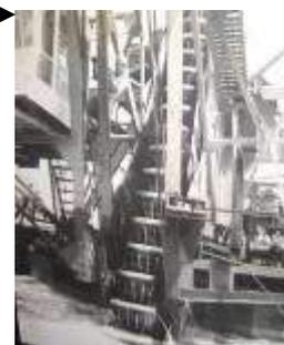
Figura 56 – Draga Alcatruz: caçambas retirando conchas da Lagoa de Araruama (Arquivo CNA, sem data).
