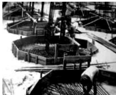
Figura 27 - Silos de cal e barrilha: fundações (CNA, 1956).
